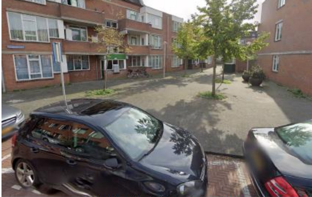
huidige situatie binnenplaats gezien vanaf Durbanstraat
